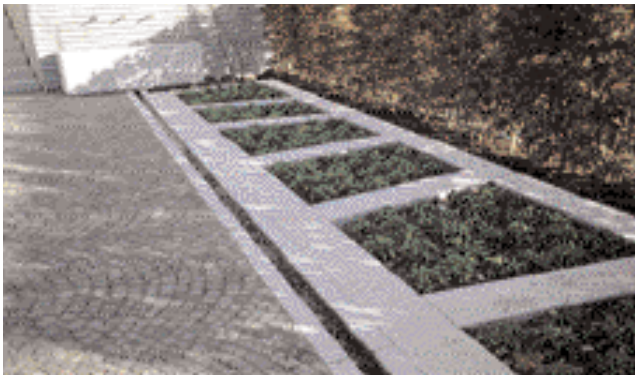
Eine Wasserrinne aus Granit-Werksteinen trennt die Terrasse von sechs kleinen Beeten
