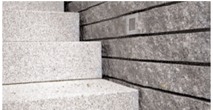
Blockstufen aus Granit und Treppenwange aus krustenrauen Platten mit Sägespuren und exakten Aussparungen für Einbaustrahler
